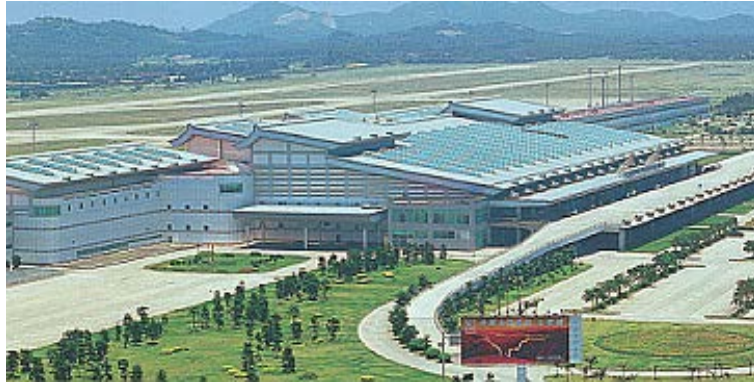
图 1-9 福州长乐国际机场候机楼折板结构
